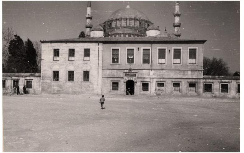
Medresetü'l-Vaizin'in Süleymaniye'deki Binası. Kapının üzerinde kitabe ve tuğra görünmekte. 1940-1950 arası. (Fotoğraf: Ekrem Hakkı Ayverdi. SALT Araştırma fotoğraf arşivi)
