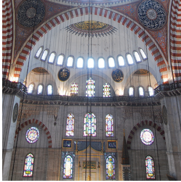
Süleymaniye Camii'nde mihrap cephesi pandantif yazıları (Restorasyon öncesi)
