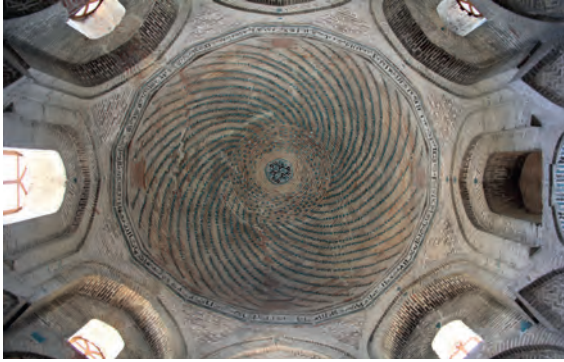
Görsel 6: Malatya Ulu Camii Mihrap Önü Kubbesi ve Kubbe Tezyinâtı (Erdal Elmas'tan).
