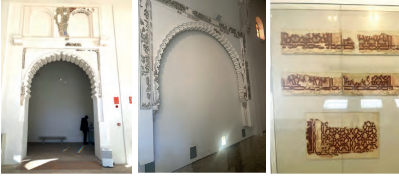
Resim 25-26-27: Avludan Salonlara Giriş Kemerleri, Salon Giriş Kemerlerinden ve Cephe Süslemelerinden Kalıntılar
