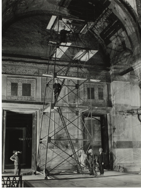
Ayasofya'nın müzeye çevrilmesinden sonra tavanında Bizans mozaiklerinin restorasyonu esnasında (Hayrullah Cengiz arşivi)
